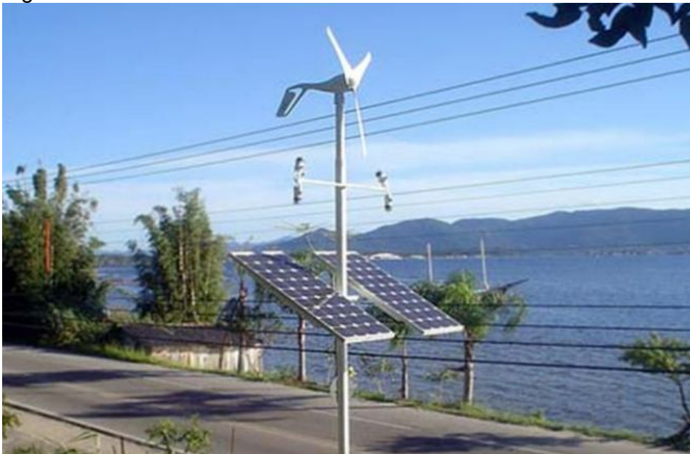
Figura 09 – Sistema híbrido eólico-fotovoltaico.
