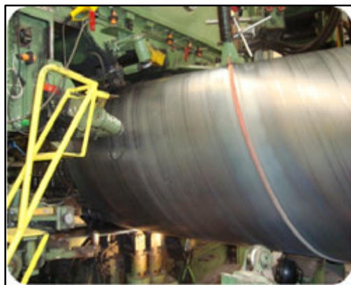
Figura 9 - Processo de Soldagem: Externo e Interno
