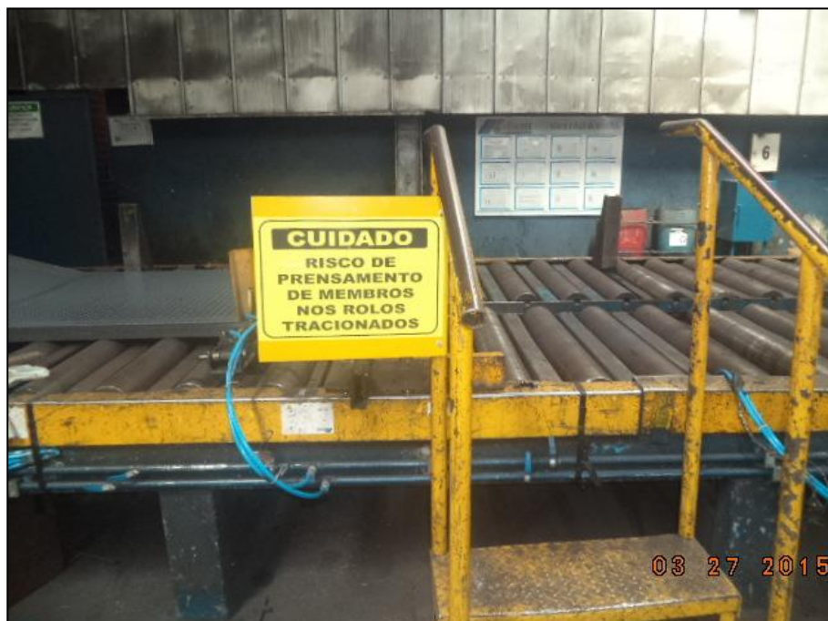
Figura 9 - Placas de advertência como medida de segurança
