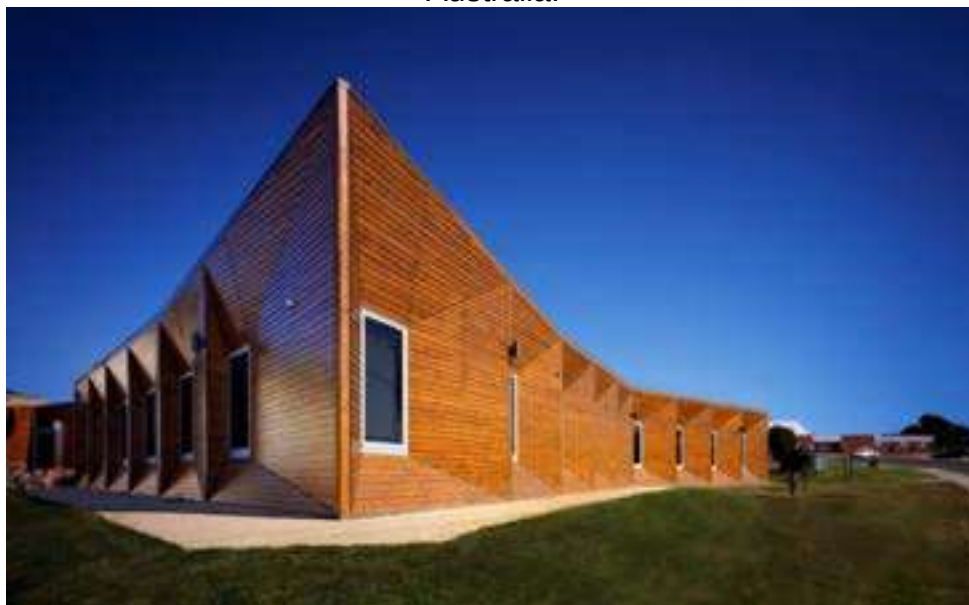
Figura 3 – Fachada do Centro Comunitário de Reabilitação de Belmont, Austrália.
