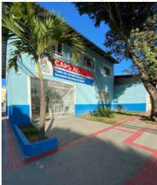
Figura 10 - Fachada CAPS AD - Vila Velha
