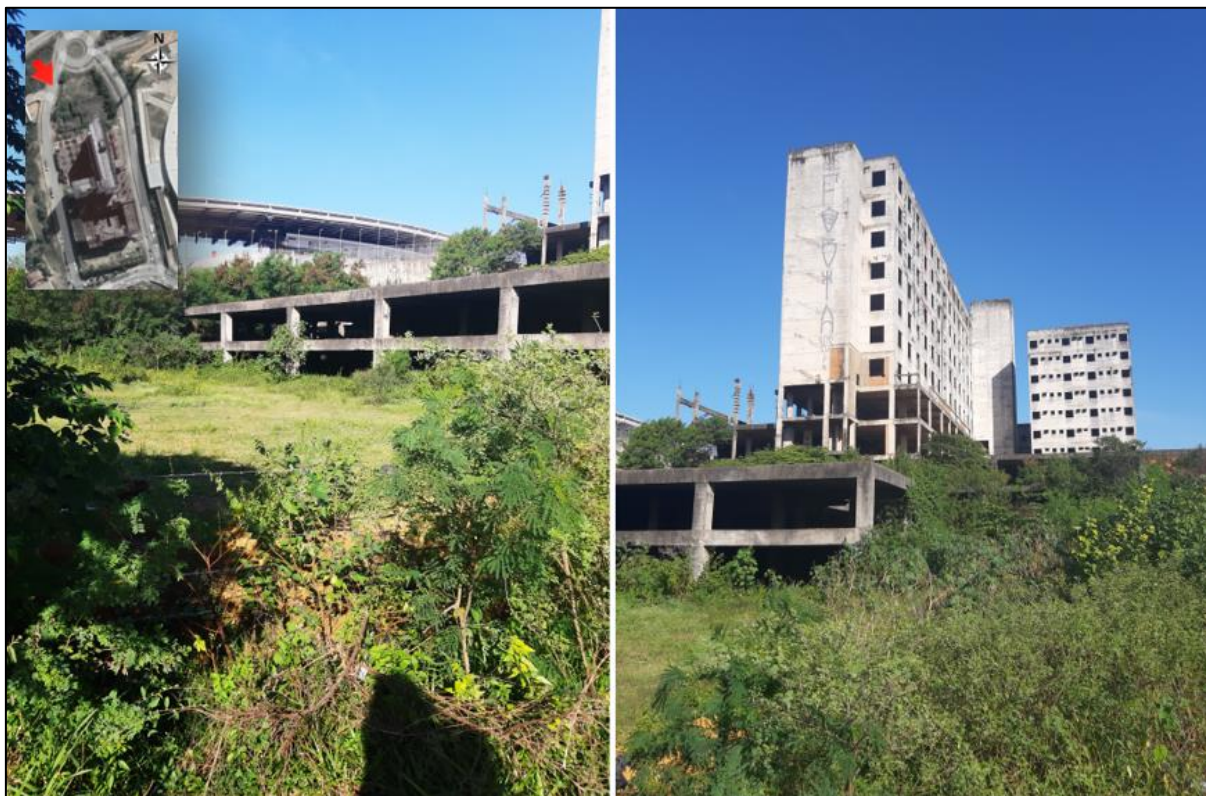
Imagem 15 – Levantamento Fotográfico: Fundos
