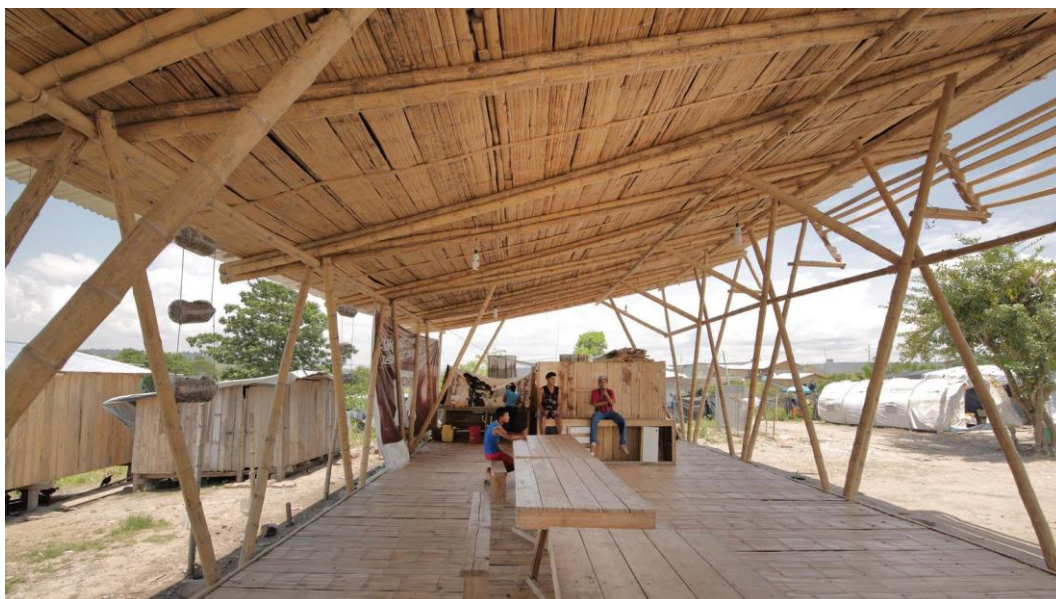
Figura 11 – Centro Comunitário Renascer de Chamanga
