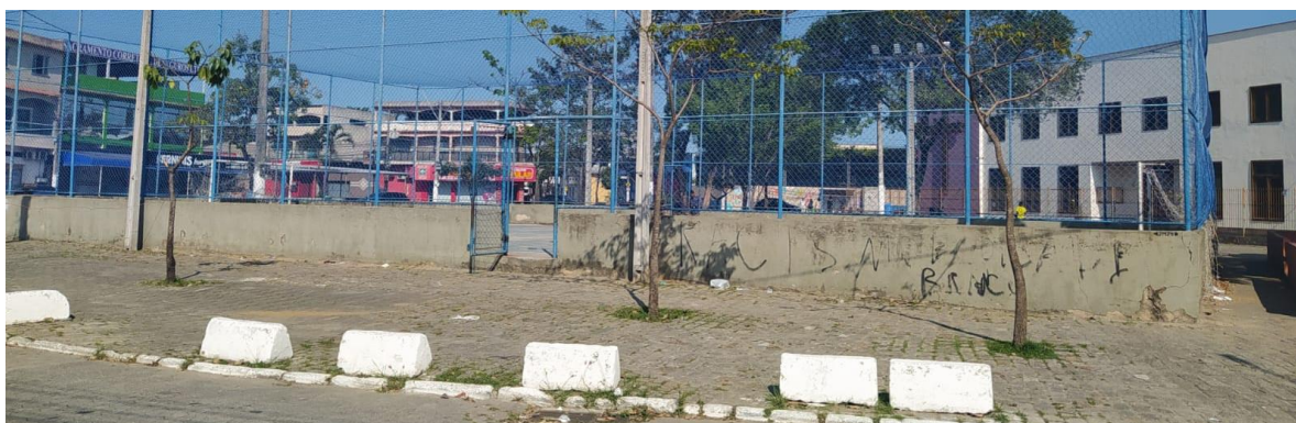
Figura 28 - Espaço vago para a implantação do pump track
