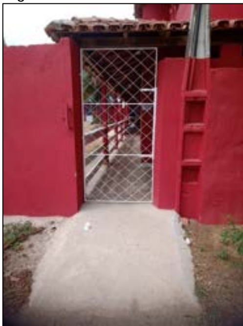
Figura 15 – Entrada dos Funda
