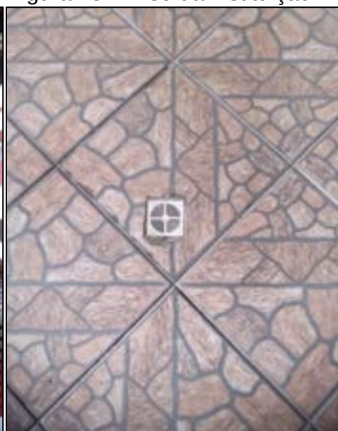
Figura 25 – Piso da instituição.
