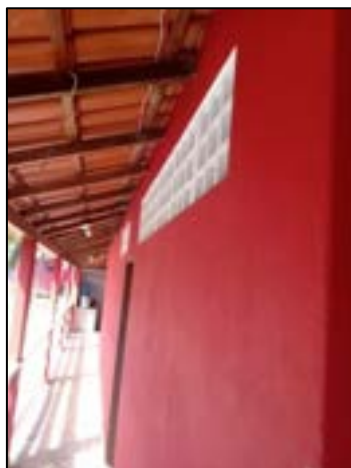
Figura 28 – Paredes Laterais com Cobogós
