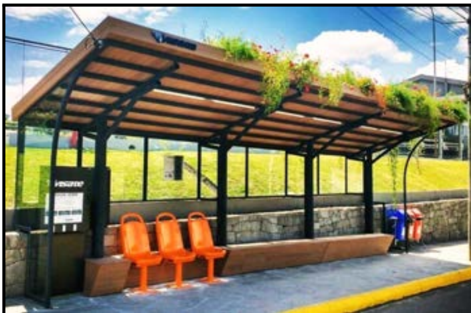
Figura 18: Abrigo do ponto de ônibus Caxias do Sul 01.
