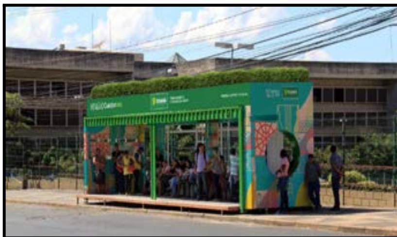
Figura 15: Abrigo de ponto de ônibus em contêiner 02.
