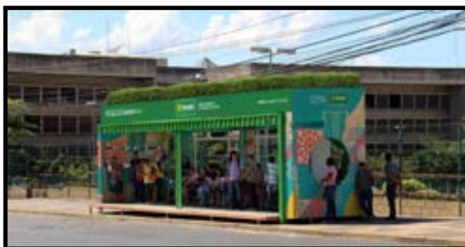
Figura 17: Abrigo de ponto de ônibus em contêiner 04.
