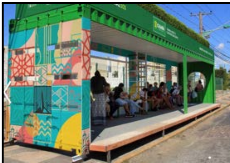
Figura 14: Abrigo de ponto de ônibus em contêiner 01.
