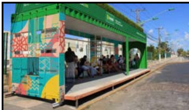
Figura 16: Abrigo de ponto de ônibus em contêiner 03.
