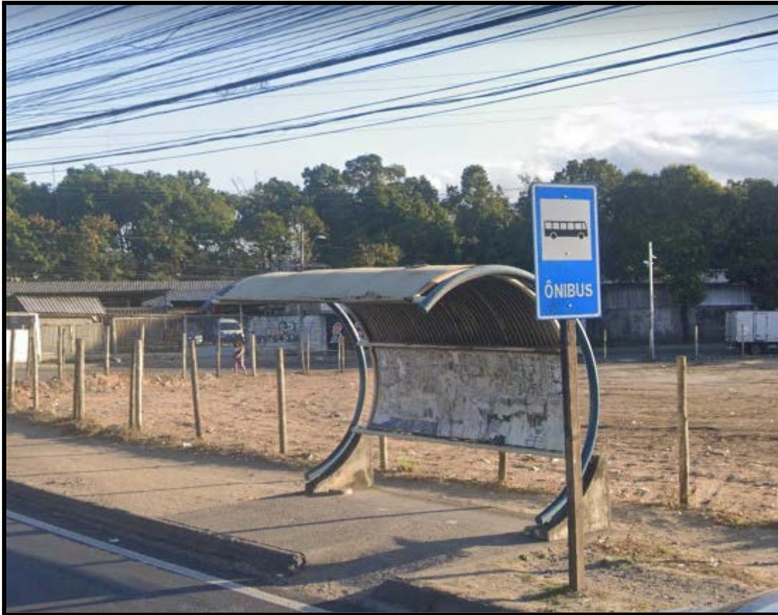
Figura 21: Ponto de ônibus Carapina.
