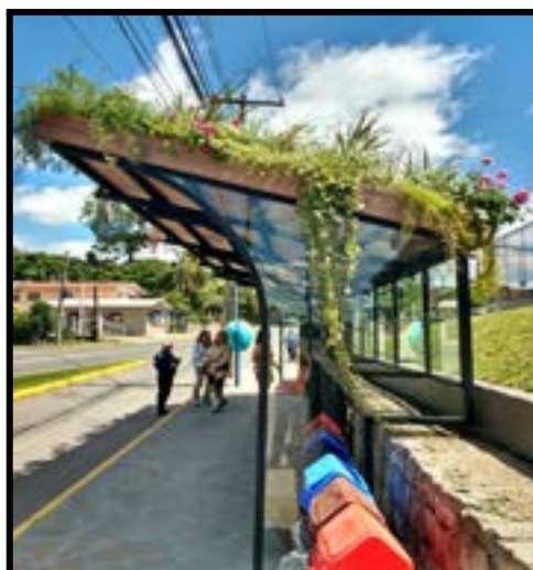
Figura 19: Abrigo do ponto de ônibus Caxias do Sul 02.
