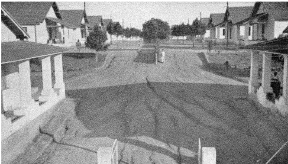
Foto 07: Área doente - portão de entrada mostrando, à direita, a varanda do refeitório geral e, à esquerda, a varanda do pavilhão da policlínica. Ao alto, a avenida central do leprosário.
