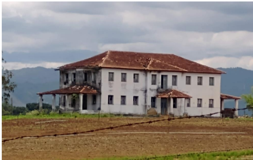
Foto 43: Fachada principal da Granja Eunice Weaver. Fonte: Arquivo da autora (2021).
