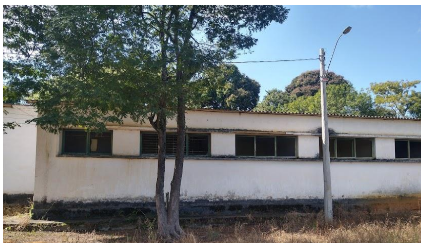
Foto 48: Fachada do centro cirúrgico atualmente.
