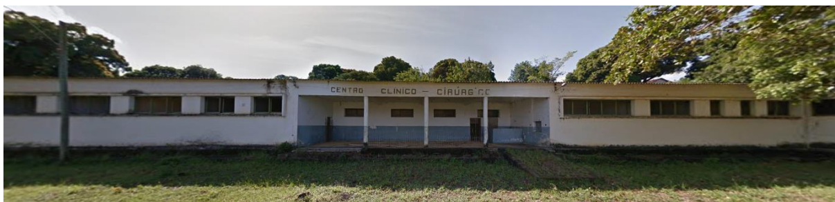
Foto 49: Fachada do centro cirúrgico atualmente.
