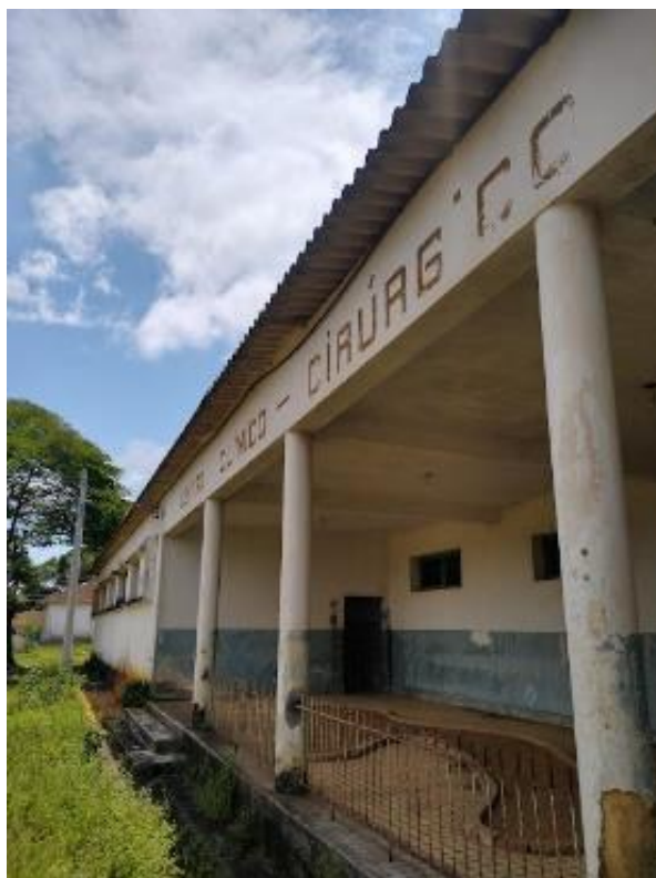
Foto 50: Fachada do centro cirúrgico atualmente.
