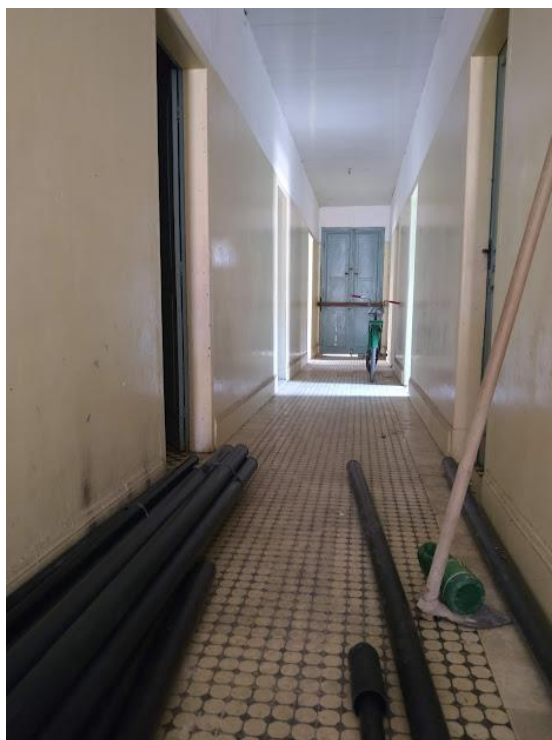
Foto 57: Interior de um dos pavilhões atualmente. Fonte: Arquivo da autora (2021).
