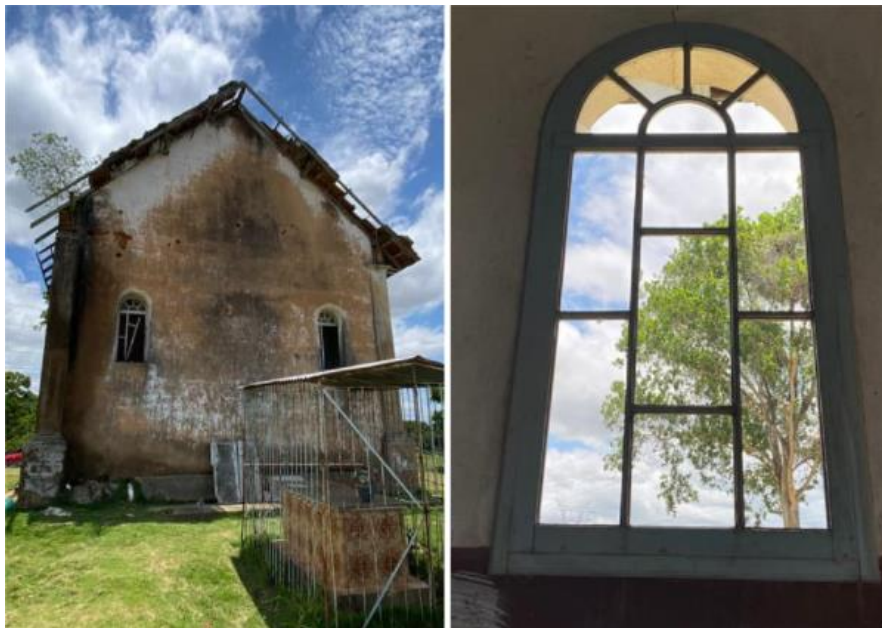
Foto 66: Detalhes da capela atualmente. Fonte: Arquivo da autora (2021).
