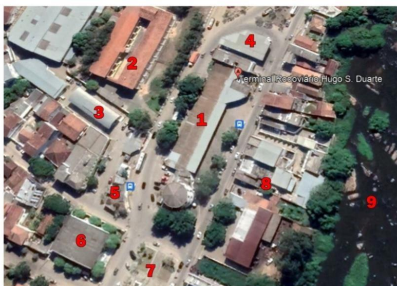
Figura 15 - Localização do Terminal Rodoviário de Nanuque MG e seu entorno
