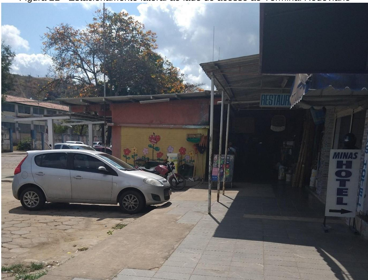
Figura 21 - Estacionamento lateral ao lado do acesso ao Terminal Rodoviário
