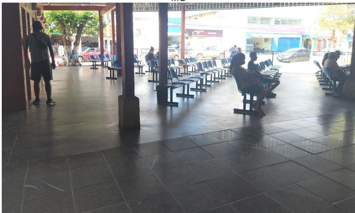
Figura 32 - Diferença de piso na área de espera do terminal rodoviário de Nanuque MG
