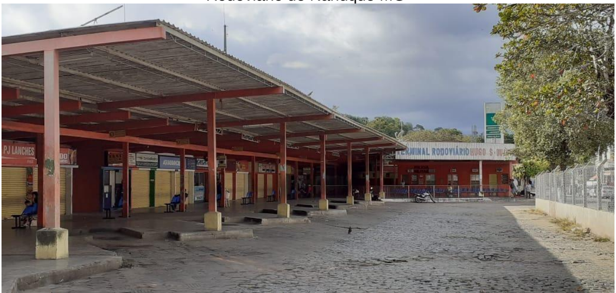
Figura 18 - Fachada Frontal área de embarque e desembarque do Terminal Rodoviário de Nanuque MG
