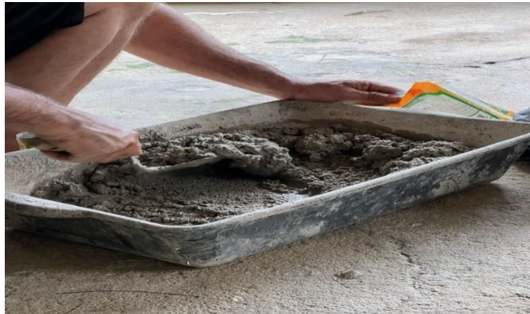
Figura 5 – Preparação da argamassa com o aditivo sika 1
