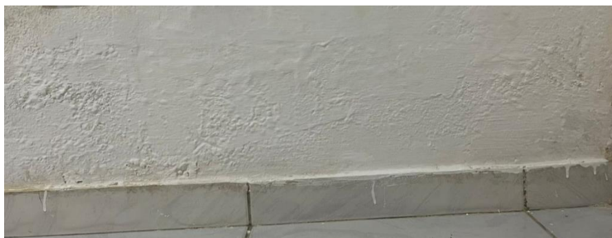
Figura 7 – Parede finalizada com a aplicação da tinta impermeável
