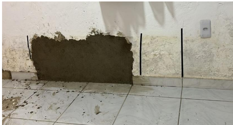
Figura 6 – Parede finalizada com a aplicação da argamassa com sika 1
