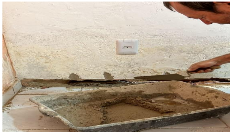
Figura 4 – Aplicação da Argamassa REBOTEC
