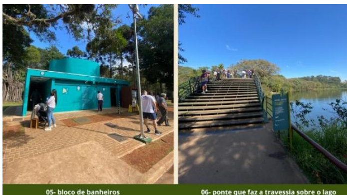
05- bloco de banheiros
