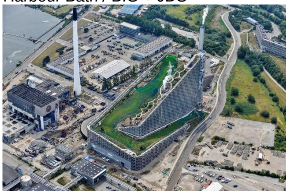
Fig 03 - Usina de energia e centro de recreação urbana CopenHill, Copenhagen Harbour Bath / BIG + JDS
