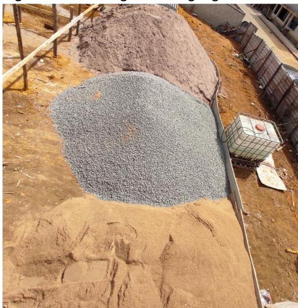
Figura 9: Estocagem de agregados
