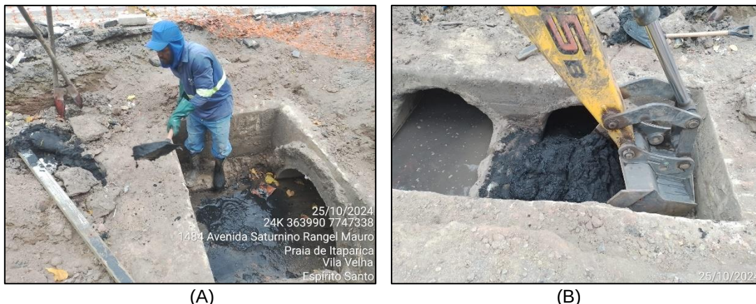
Figura 08 – (A) Limpeza de forma manual (B) Limpeza com apoio da retroescavadeira
