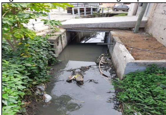
Figura 9 – Galeria de drenagem pluvial
