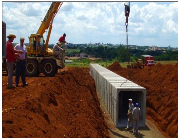
Figura 6 - Galeria de água pluviais
