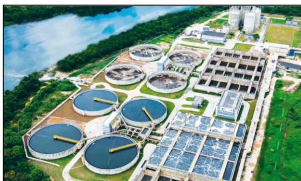
Figura 4 – Estação de tratamento
