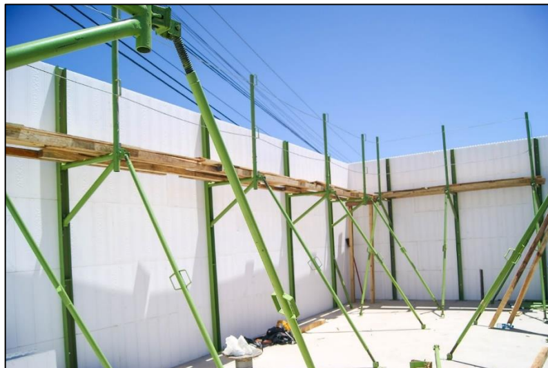
Figura 6 – Alvenaria de ICF com escoramento
