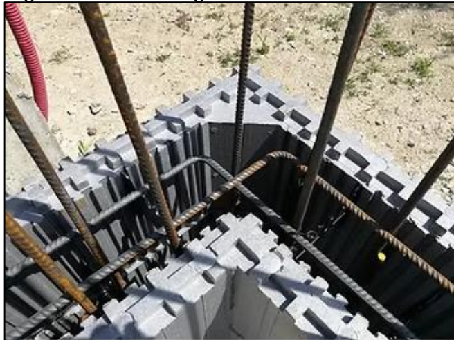
Figura 14 – Ancoragem das formas de EPS
