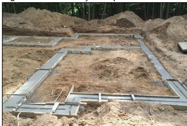
Figura 12 – Fundação sapata corrida
