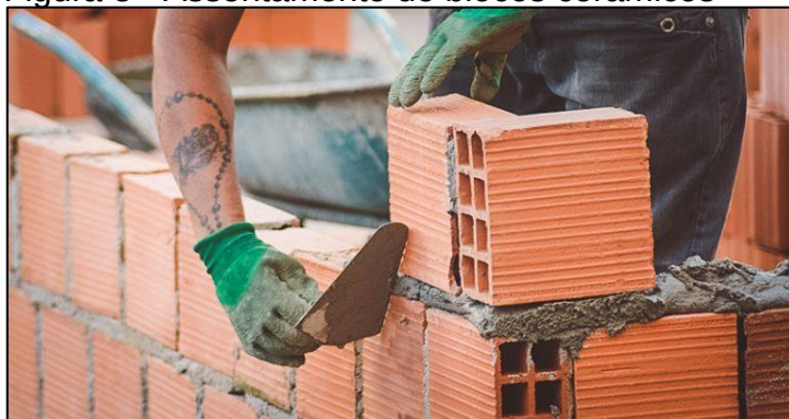
Figura 3 - Assentamento de blocos cerâmicos
