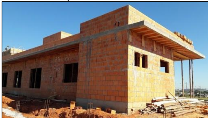
Figura 2 – Construção em alvenaria de concreto armado
