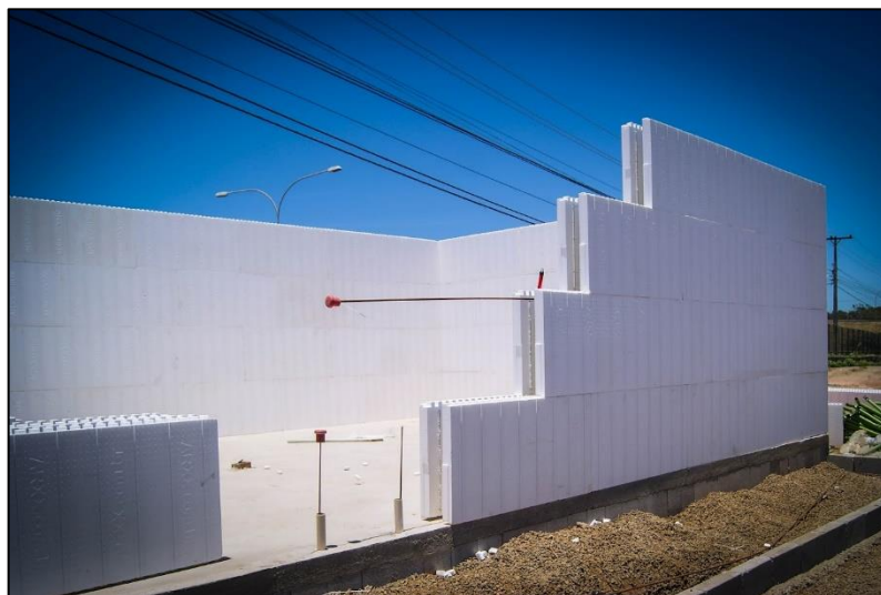
Figura 5 – Alvenaria de ICF
