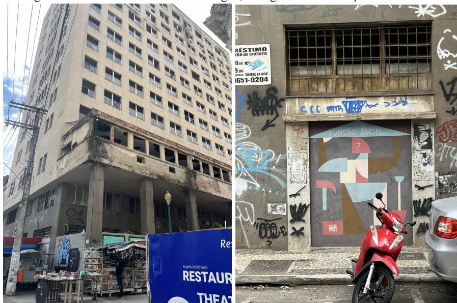
Figura 7 e 8: Edifício Presidente Vargas, Antigo IAPI e vedações das entradas.
