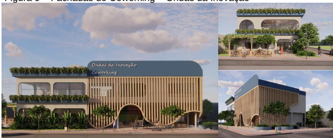
Figura 9 – Fachadas do Coworking – Ondas da Inovação
