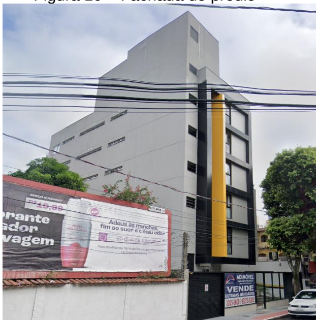
Figura 10 – Fachada do prédio
