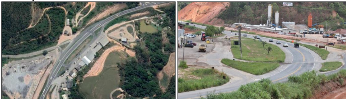
Figura 6 e 7 – Trevo de Paraju – km 57 da BR-262 -Marechal Floriano – ES, antes de realocação de trecho
