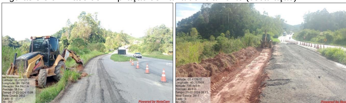
Figuras 8 e 9 – Fase de Ampliação de Faixa de rolamento (escavação)
