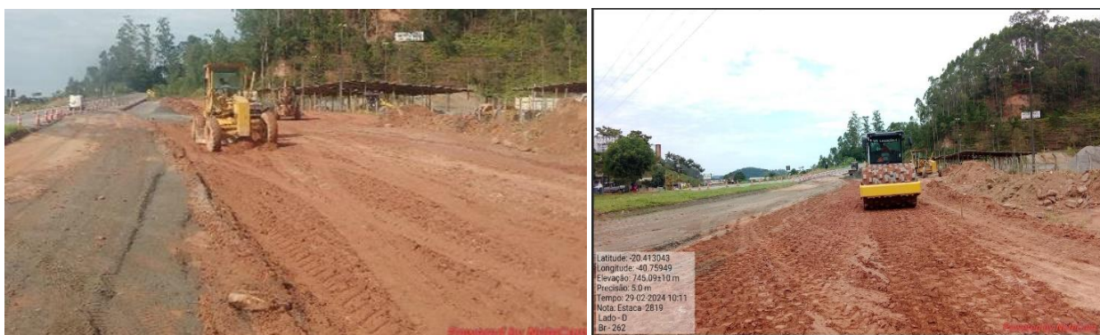
Figuras 10 e 11– Compactação e Adensamento de Solo
