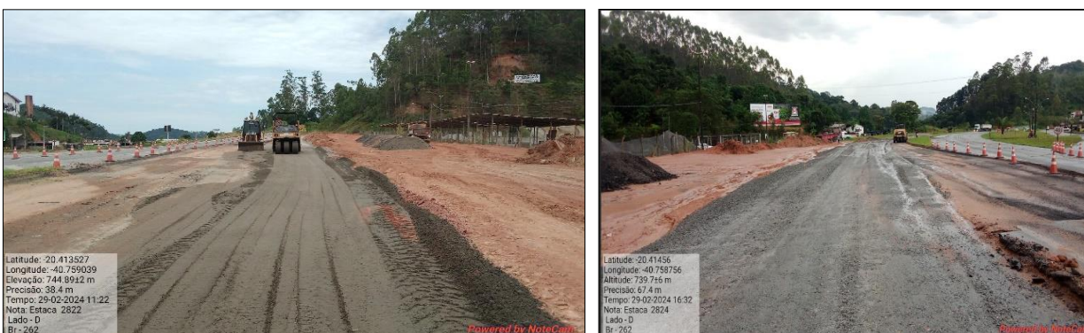
Figura 12 e 13 – Aplicação de BGS para base
