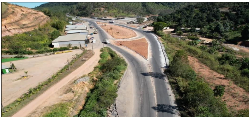
Figura 15 - Trevo de Paraju durante aplicação de nova realocação
