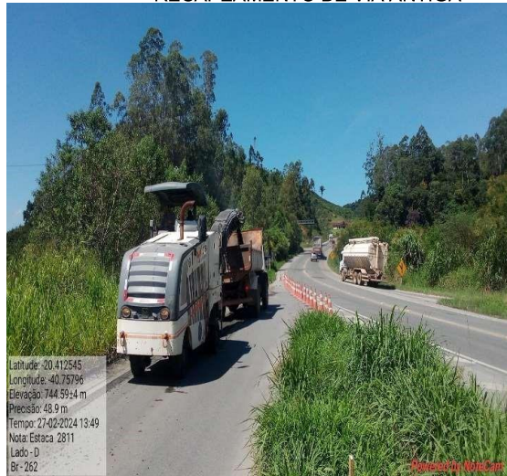
RECAPEAMENTO DE VIA ANTIGA
